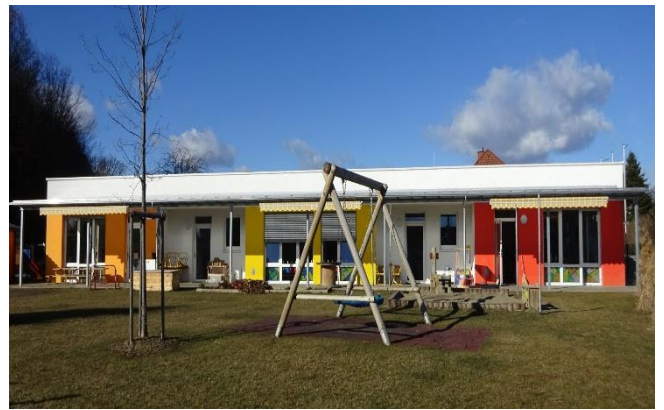
Außenansicht des Kindergartens
